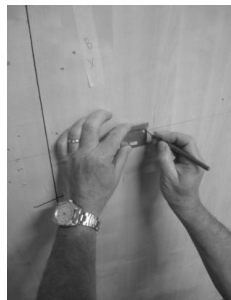
2 Positionner le gabarit, tracer et percer
