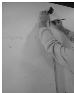
1 Déterminer la hauteur de pose finale
