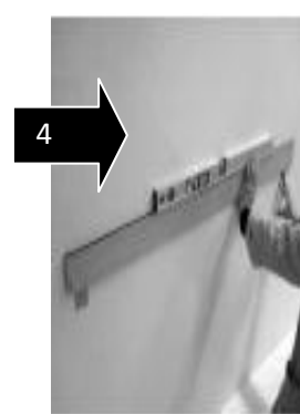
4 Placer la deuxième patte murale en l'alignant de niveau avec la première
