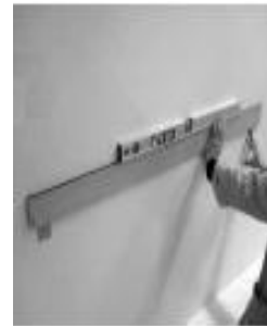
4 Placer la deuxième patte murale en l'alignant de niveau avec la première
