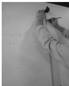
1 Déterminer la hauteur de pose finale
