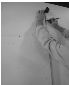
1 Déterminer la hauteur de pose finale
