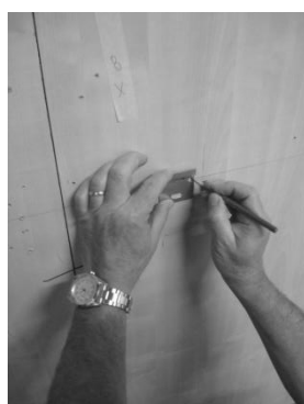
2 Positionner le gabarit, tracer et percer
